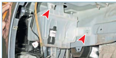
Головкой «на 10» отворачиваем три гайки крепления бачка.
