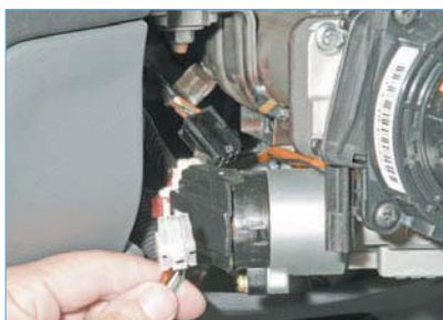
Нажав на фиксатор колодки, отсоединяем колодку проводов выключателя противотуманных фар от колодки жгута проводов.
